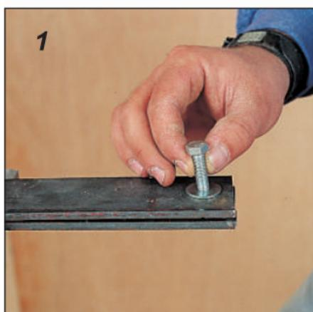
**1** Introduceți șurubul cu cap hexagonal și diametrul potrivit... fără a uita șaiba.
