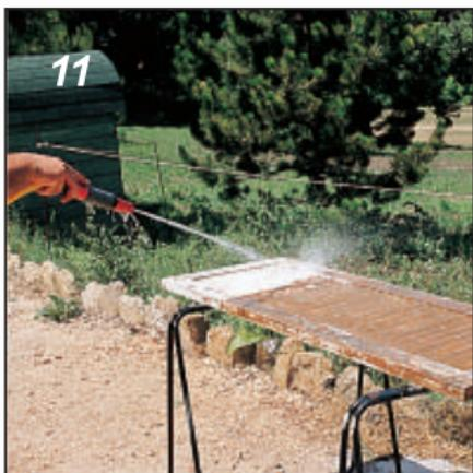
**11** Odată ce vopseaua a fost dizolvată de decapant, spălați cu jet de apă pentru a o elimina.
