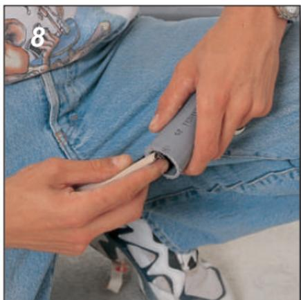
8 Șlefuiți porțiunile ce trebuie racordate: exteriorul țevii și interiorul racordului, cu hârtie de șmirghel fin, pânză abrazivă sau sărmă de oțel.
