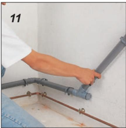
11 Introduceți bucătile de instalatie lipite în coliere.
