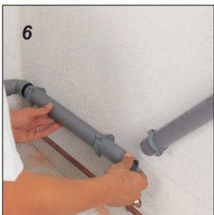
6 Efectuați montarea liberă, așezând segmentele drepte și racordurile în coliere.
