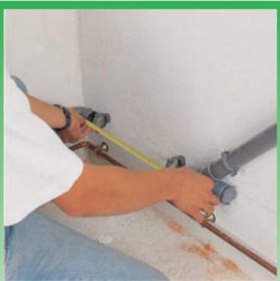
*În general trebuie măsurat ultimul tronson de instalatie dintre două ansambluri montate. Nu uitați să luați în calcul încastrările în racorduri.*
