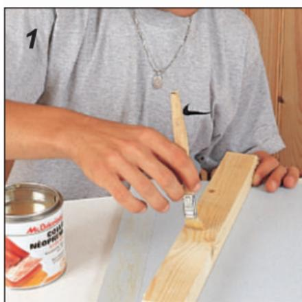
**1** Lipire dublă, lipire prin contact. Ungeți cele două suprafețe care trebuie asamblate cu un strat subțire de lipici.
