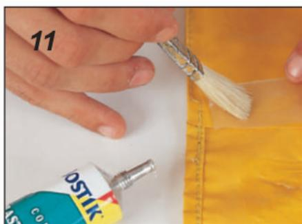
11 Lipici de contact cu poliuretan. După ce curățați suprafața respectivă cu acetonă, puneți lipiciul și aplicați o membrană din PVC transparent.
