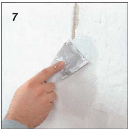
7 Umpleți fisura cu tencuială de umplere, determinând tencuiala să pătrundă adânc.
