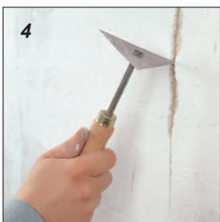
**4** O fisură trebuie să fie "deschisă" cu răzuitarul cu trei tăișuri pentru ca tencuiala de astupare să aibă o suprafață bună de agățare.
