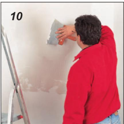
10 řpaclul de tencuit trebuie să fie ascuțit. Tești o parte a lamei cu pila plată, apoi ascuțești muchia cu piatra de ascuțit.
