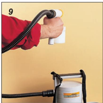
**9** Pentru a vopsi un perete sau o suprafață plană, proiectați un strat fin și regulat, deplasând pistolul orizontal. Porniți din partea de sus...
